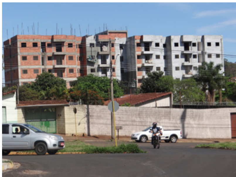
Porto de Itália - Primeiras unidades em fase de acabamento
